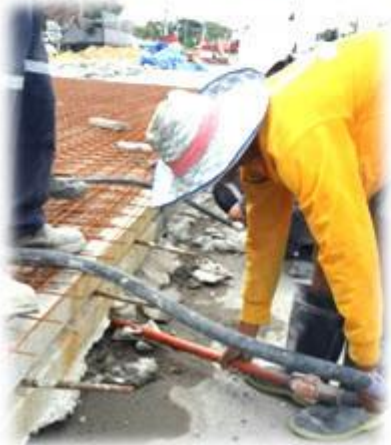
ภาพตัวอย่างการใช้เครื่องพ่นปูนฉาบ ชนิดสกรูบีม ในการบ่มปูนเกร้าต
