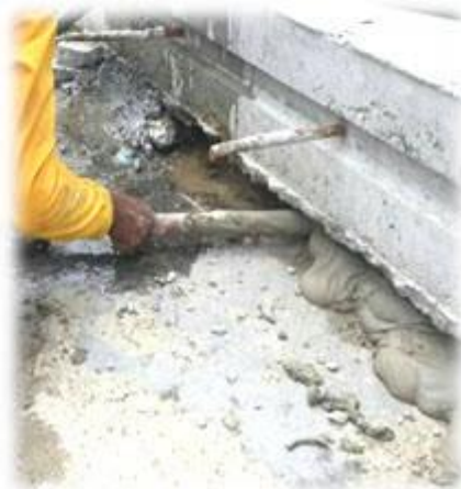
ภาพตัวอย่างการใช้เครื่องพ่นปูนฉาบ ชนิดสกรูบีม ในการบ่มปูนเกร้าต
